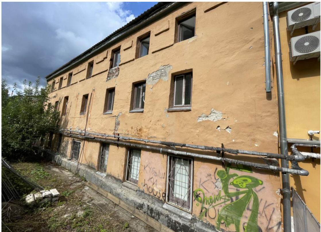
Илл. 6. г. Нижний Новгород ул. Кожевенная. 12. Участок проектирования. Дворовой фасад здания.
